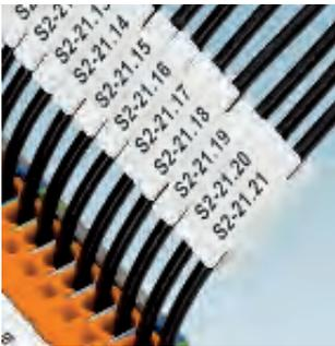
Пластины UniCard для маркировки проводов, нанесение надписей принтером BLUEMARK WMC...
